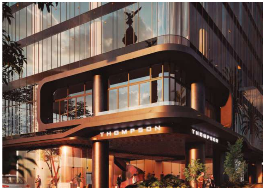
LA TORRE THOMPSON MEXICO CITY, EL PRÓXIMO ÍCONO URBANO QUE YA ESTÁ EN CONSTRUCCIÓN.
