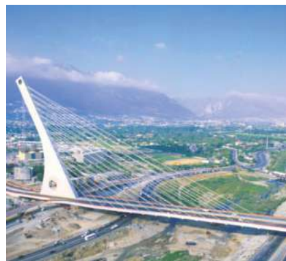
PUENTE LA UNIDAD, CONSTRUIDO EN 2003 EN MONTERREY.
